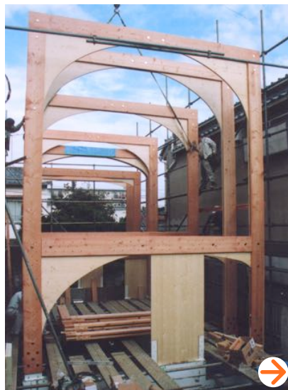
■ Oval Panel で補強された薄い柱梁
