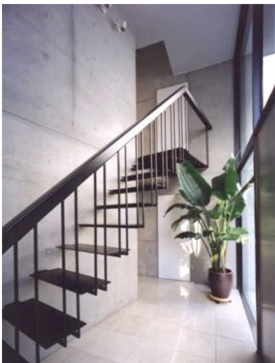
■ エントランス。手摺を構造体とした吊構造の階段
