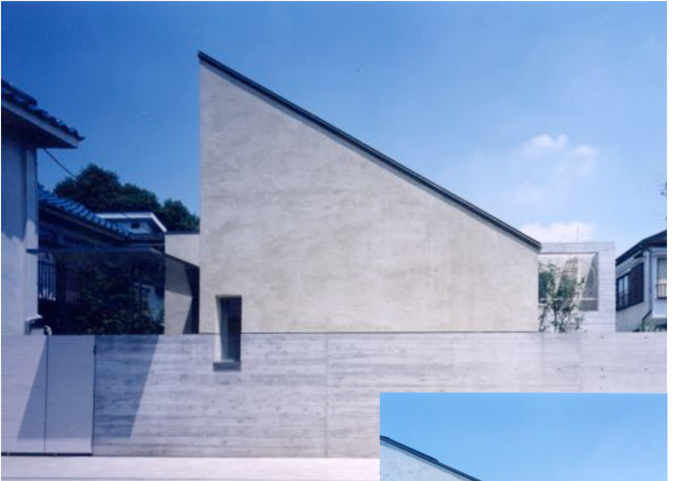
■ プライバシーの高い外観。太陽熱を利用する片流れ屋根に特注の左官仕上。
