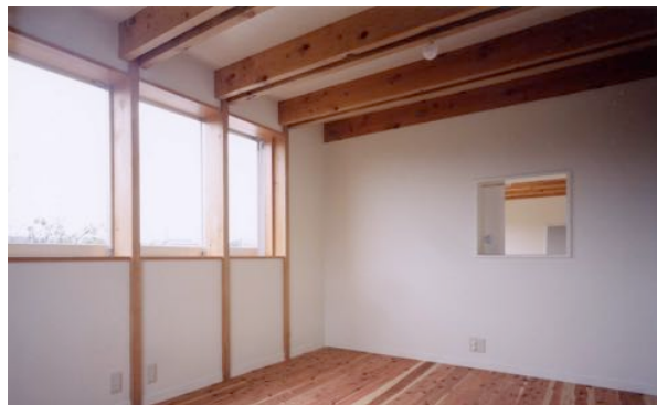
■ 将来用の子供室。個室にも柱、梁の構造が露出する。右側の小窓からは居間への吹き抜けが見おろせる。
