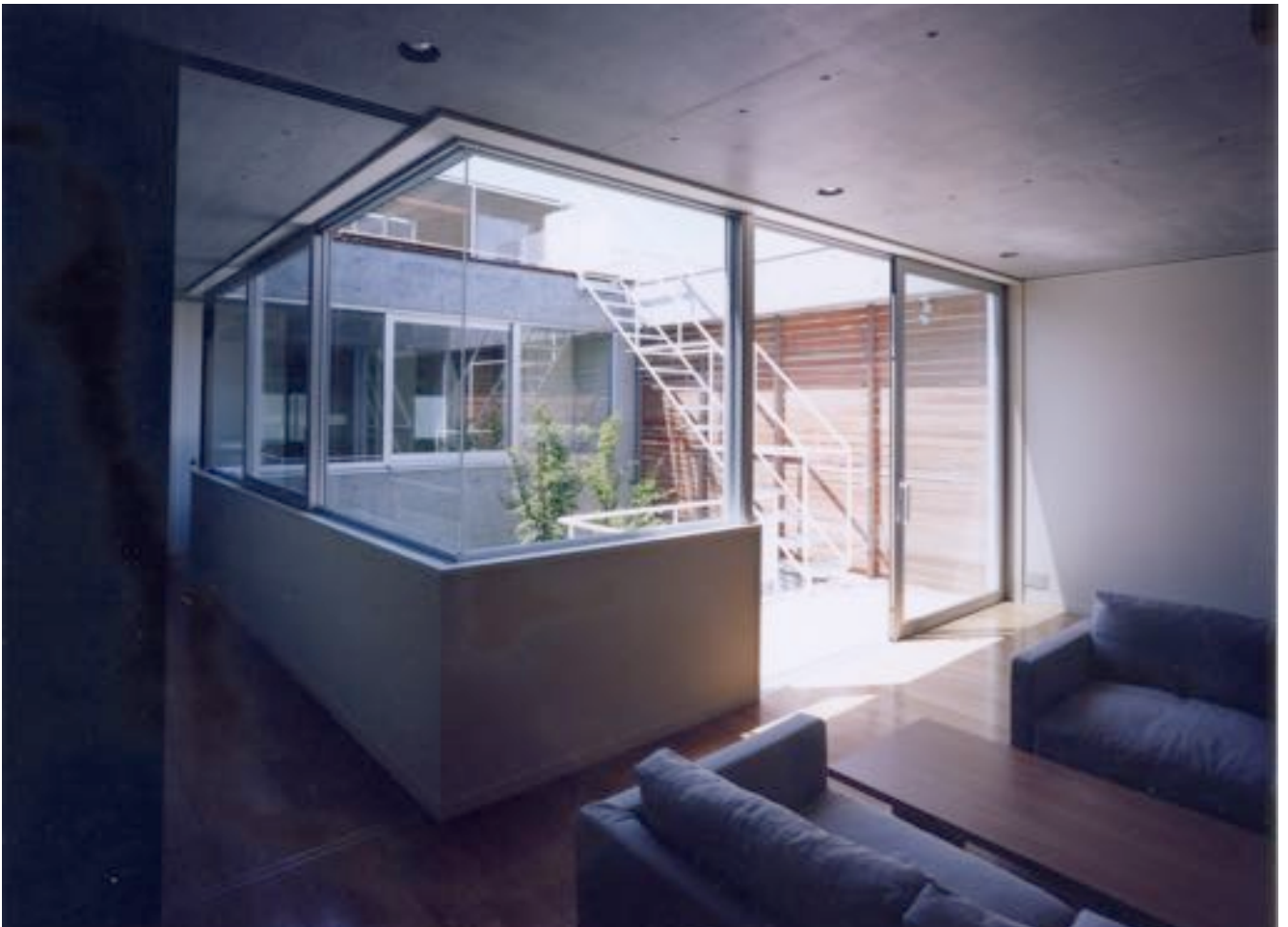
■ 居間より中庭方向。 外観からは想像できない開放的な空間。外周以外は構造壁が必要ないため中庭はガラスで囲まれる。
