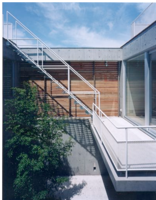
■ 2階の廊下より中庭を見る。正面は屋上への階段。
