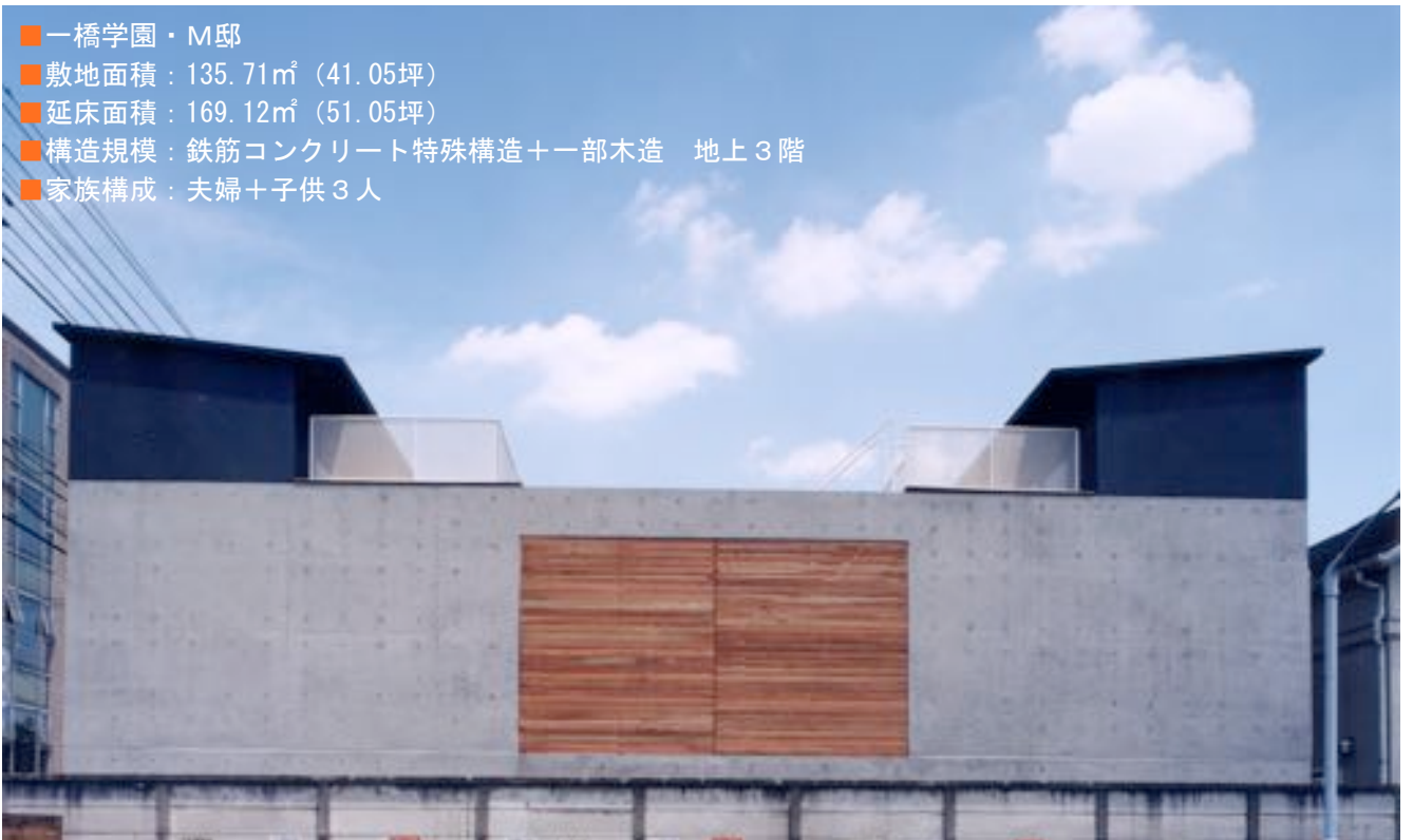
■西側外観。3階の黒い部分が木構造。
