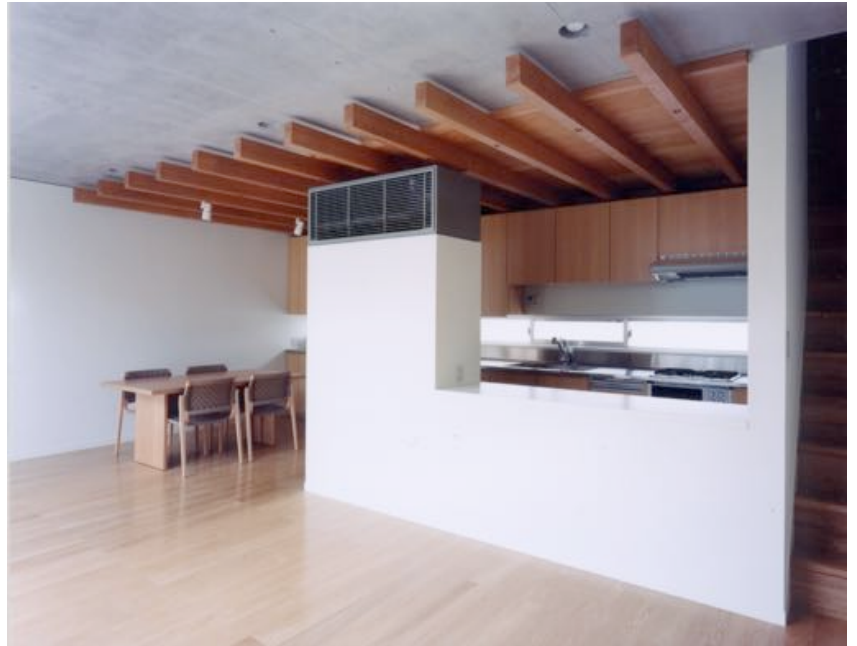
■ 2階リビングよりキッチン方向。天井の木は3階木造部を支える梁。
