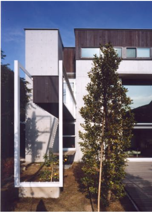
■ 2階 サルームから延びるブリッジ状のテラス
